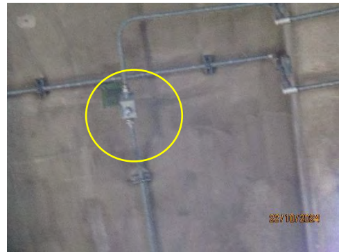
ภาพที่ 2-22 Heat Detector
