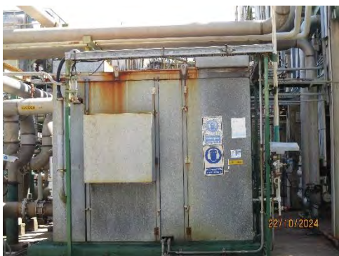
ภาพที่ 2-12 ถังครอบลดเสียงดังจากเครื่องจักร และป้ายเตือนให้สวมใส่อุปกรณ์ป้องกันเสียงดัง
