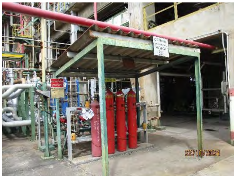
ภาพที่ 2-4 ถังก๊าซ CO เพื่อใช้ในระบบ CO Injection
