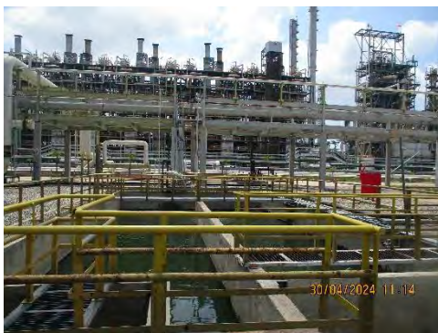
API Separator (ใช้ร่วมกันกับ PP1)
