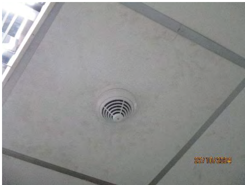
ภาพที่ 2-21 Smoke Detector
